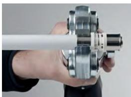
Pressvorgang mit einer U-Kontur (und H-Kontur): Das Presswerkzeug ansetzen und auf die Edelstahlhülse zwischen dem Kunststoffring und dem äußeren Ende der Presshülse aufsetzen. Danach den Pressvorgang (je nach Maschinentyp) auslösen. Der Pressvorgang ist beendet, wenn der vollständige Pressbackenschluss erreicht ist. Es müssen 3 Rillen auf der Edelstahlhülse gleichmäßig umlaufend sichtbar sein.
