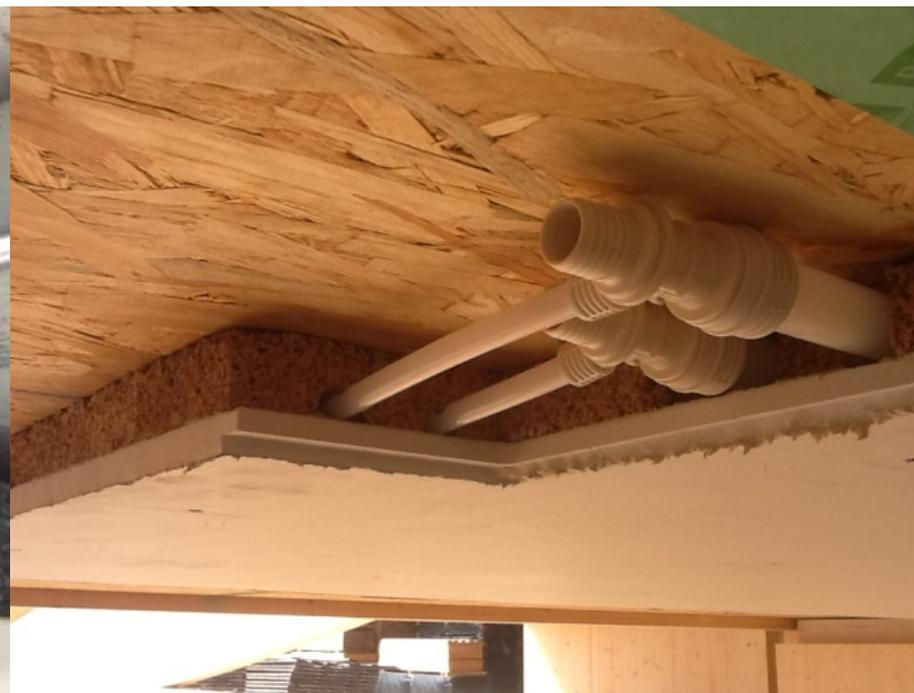
In Sonderfällen und mit spezifischen Vorkehrungen kann die Aufbauhöhe bedeutend reduziert werden.
