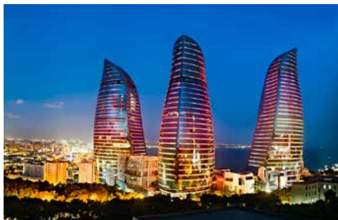
Flame Towers - Aserbaidshan - Mini Canal
