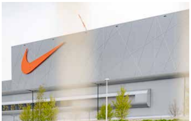
Nike Distributiecentrum - Belgien - AVS Luftheritzer
