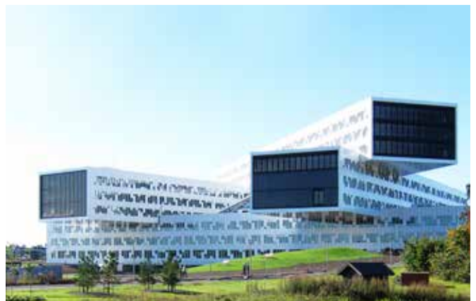
Statoil HQ - Norwegen - Mini Canal
