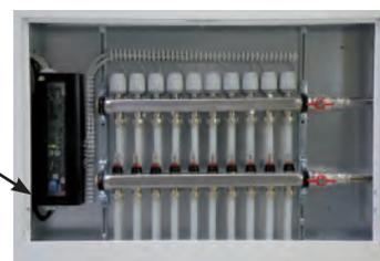
Zonenmodul im Fußbodenverteilerkasten
