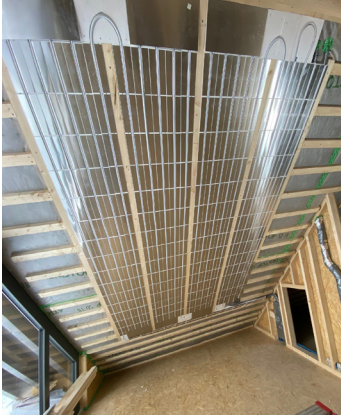
Deckenheizung / Kühlung
