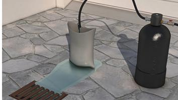
Spülen Sie solange, bis wieder klares Wasser aus dem Spülschlauch kommt. Schließen Sie den Kugelhahn und die Wasserzufuhr.
