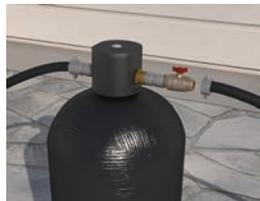
Schließen Sie einen am Wassernetz angeschlossenen Schlauch am Kugelhahn an.
