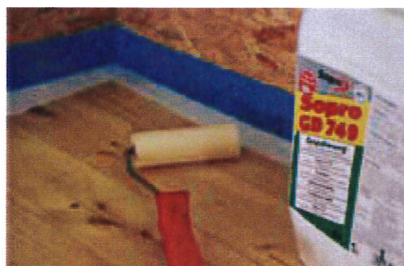
65. Bodenausgleich mit Fließspachtelmasse
