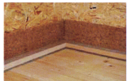
66. Beginn der Verlegung
