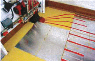
19. Verlegung der Wärmeleitabdeckbleche
