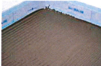
85. Aufbringen des Fliesenklebers
