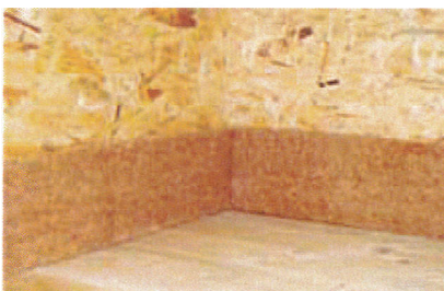
64. Verlegung des Randdämmstreifens
