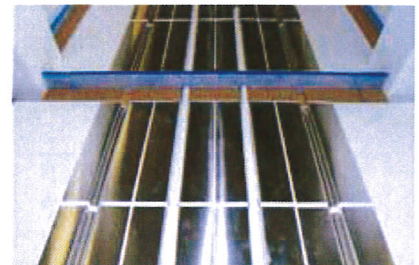
51. Auffüllen von Hohlstellen
