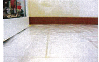
21. Aufbringen der Gleitschicht
