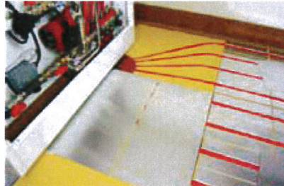
20. Höhenkontrolle am Verteilerschrank
