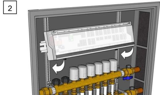
Basis leicht gekippt auf die Hutschiene aufsetzen und einrasten lassen.
